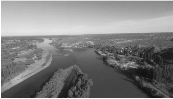
Fig. 3.7.5 Desvío de cauce de ríos
